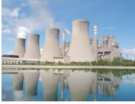
MARAŞ ELBİSTAN TERMİK SANTRALİ
